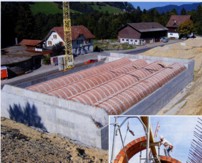
Rohbau des Reifegewölbes
