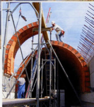
Elemente weise Montage vor Ort
