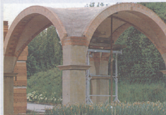
Neu bei Neuschwander: ARCasa-Fertigteile für Kreuzgewölbe
